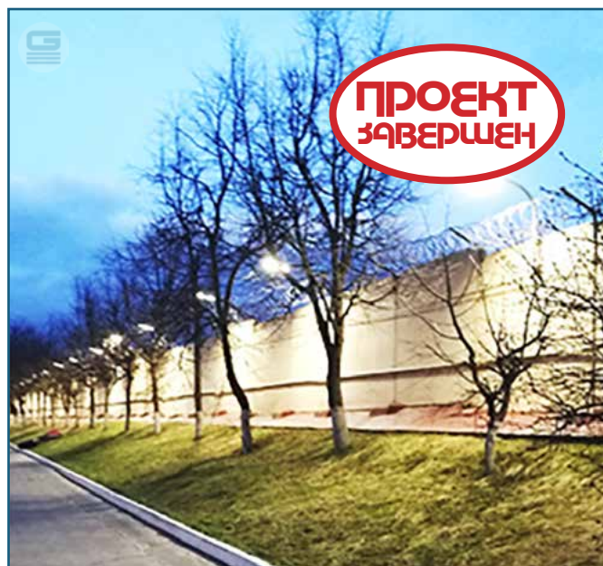
Смонтированный участок наружного освещения
